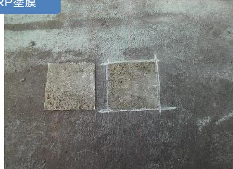
◆FRP密着防水のコンクリート躯体内部の水分(スラブ面が濡れている)
