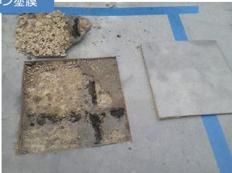
◆ウレタン塗膜防水のコンクリート躯体の劣化
