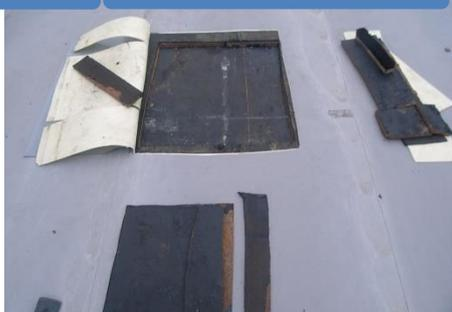
◆アスファルト防水(断熱材入り)の上に塩ビシート絶縁防水を
