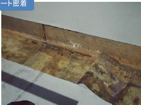
◆塩ビシート密着防水のコンクリート躯体の劣化
