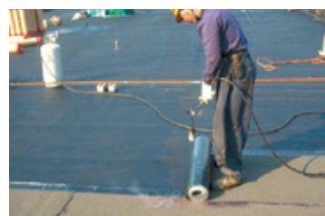
▲改質アスファルト防水 トーチ工法
