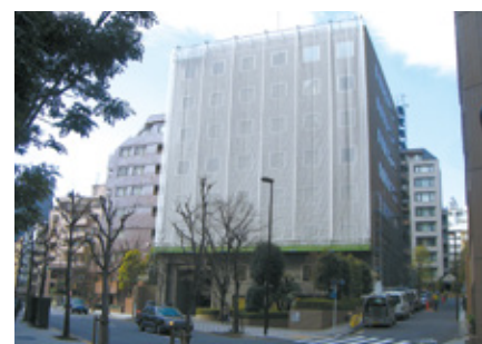
▲仮設ゴンドラ設置状況(SSP仕様)
