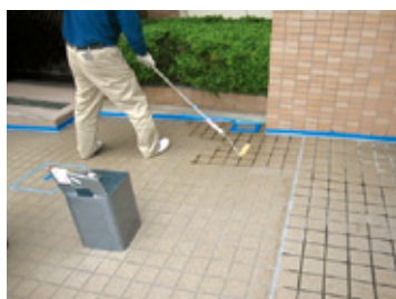
▲床用粗面保護仕上げ材塗布(タイル)
