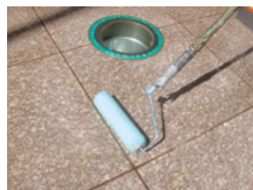
▲床用粗面保護仕上げ材塗布(御影石)
