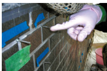
▲外壁浮き補修
