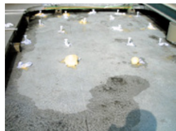
▲ビル屋上注入漏水補修
