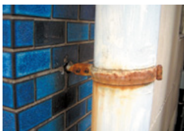
▼竖樋支持金物交換
