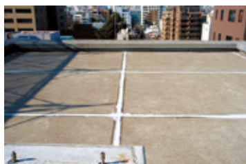
▲保護コンクリート目地シーリング
