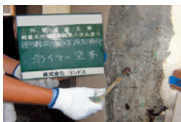
▲外壁爆裂補修(ステンレス鋼線巻付け)
