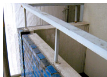
▼手摺根元金物補修
