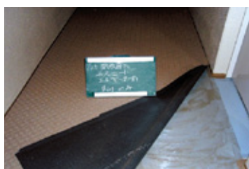
▲廊下床長尺シート張り
