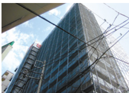
▲仮設枠組足場設置状況(透過性メッシュシート使用)
