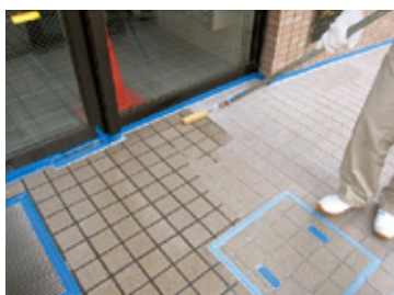
▲床用粗面保護仕上げ材塗布(タイル)
