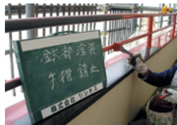
▲廊下手摺錆止め塗装
