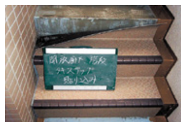
▲階段床長尺シート張り
