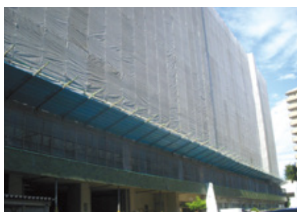
▲仮設枠組足場設置状況
