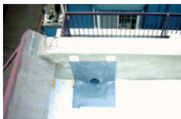
▲改修ドレン取付け
