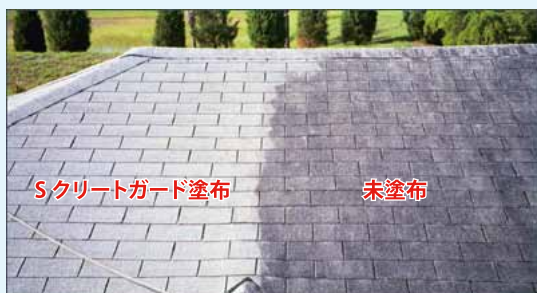
セメントタイルへの施工
