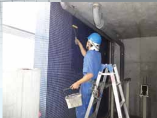
タイル面へのローラーによる施工
